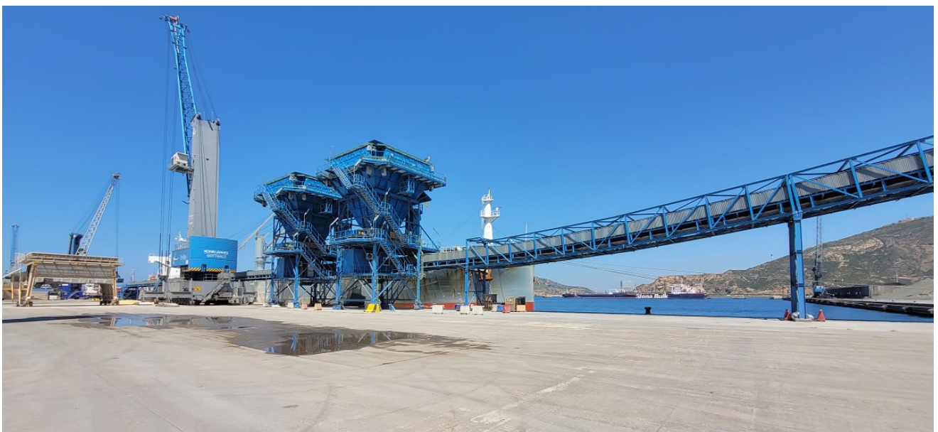
Nuevas cintas transportadoras y tolvas ecológicas para minimizar emisiones de partículas instaladas por Ership, S.A.
