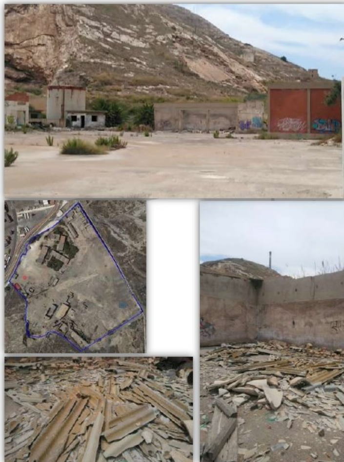
DESAMANTADO DE PLACAS DE FIBROCEMENTO EN ANTIGUA FUNDICIÓN DE SANTA LUCÍA
