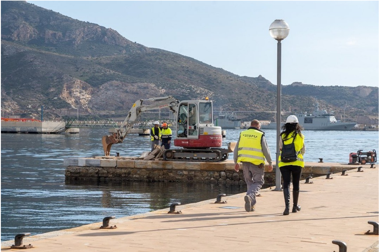
Obras en la dársena de Cartagena
