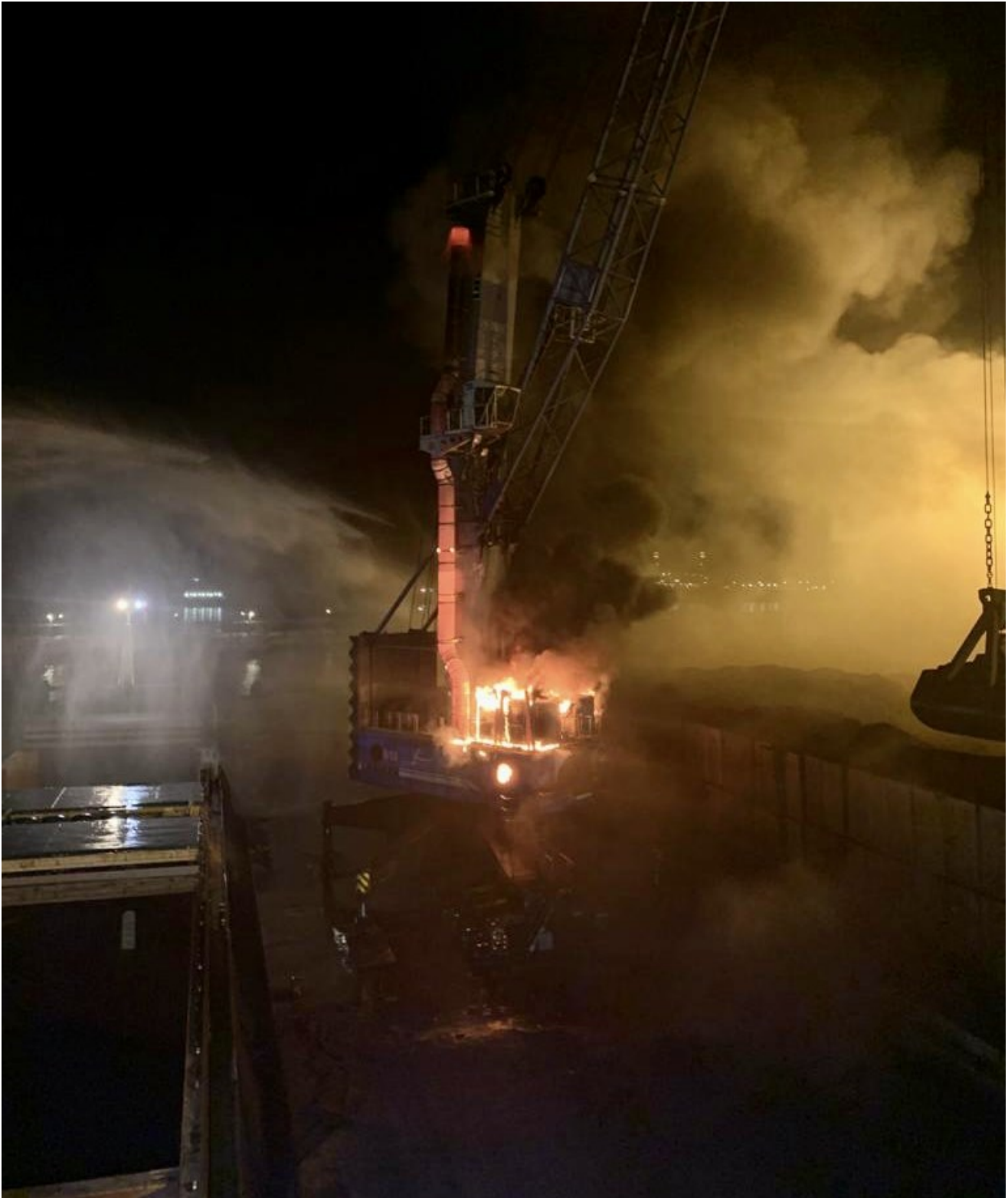
Incendio sala de máquinas en grúa 04-05-2021 no hubo daños humanos ni al resto de instalaciones gracias a la rápida actuación de los remolcadores del puerto y bomberos.
