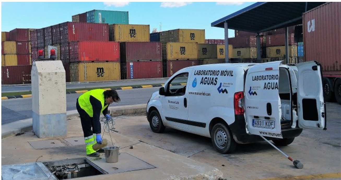
Toma de muestras en el pozo de bombeo de la Terminal de Contenedores S.Lucía
