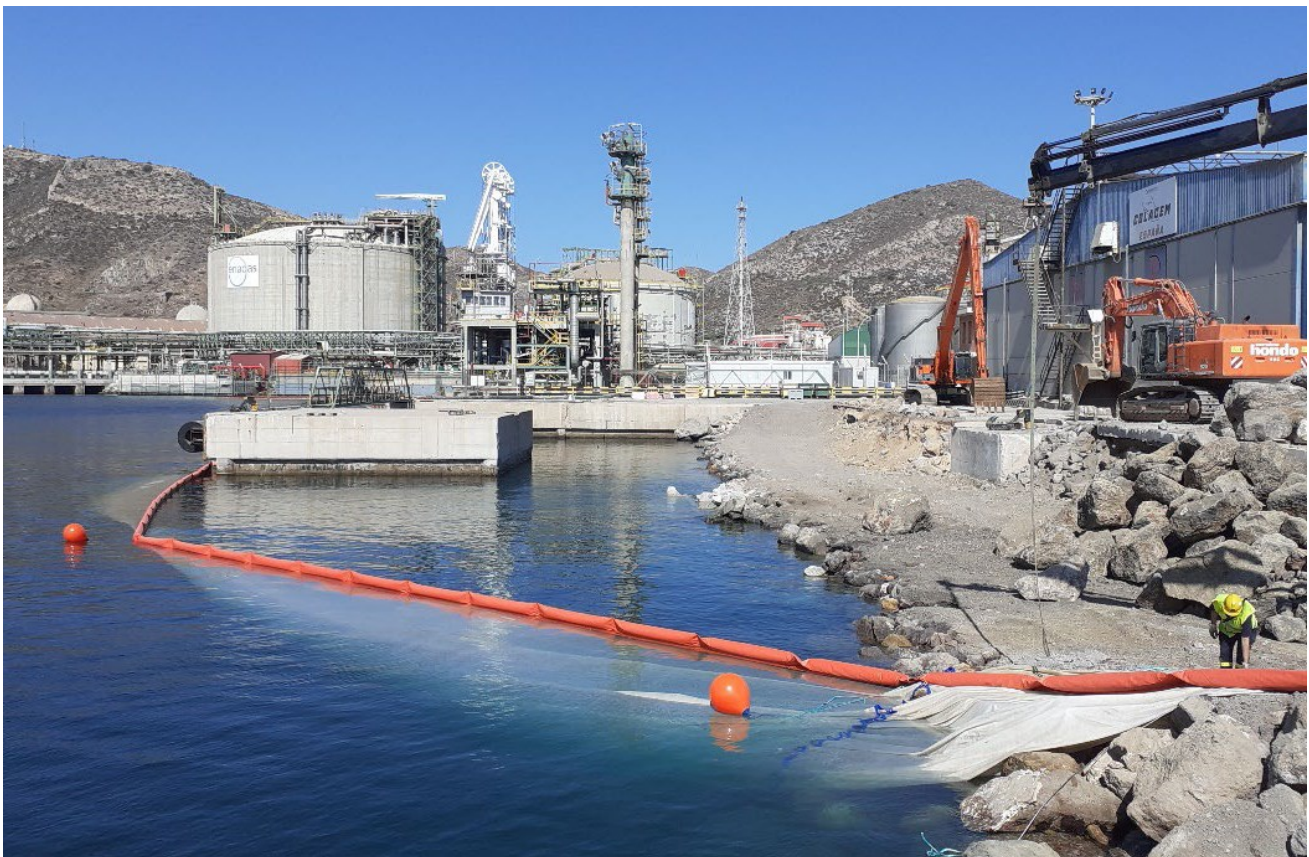
Barrera anti turbidez en las obras de ampliación del muelle para carga GNL en Escombreras
