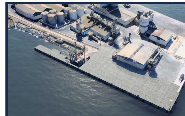
Adaptación y mejora para la carga de GNL y carga de ganado.
