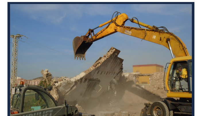
Demolición de las instalaciones de la antigua fundición de Santa Lucía.
