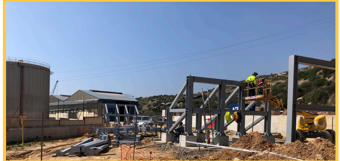
Prolongación rack de tuberías hasta el límite de la zona de servicio de El Fangal.
