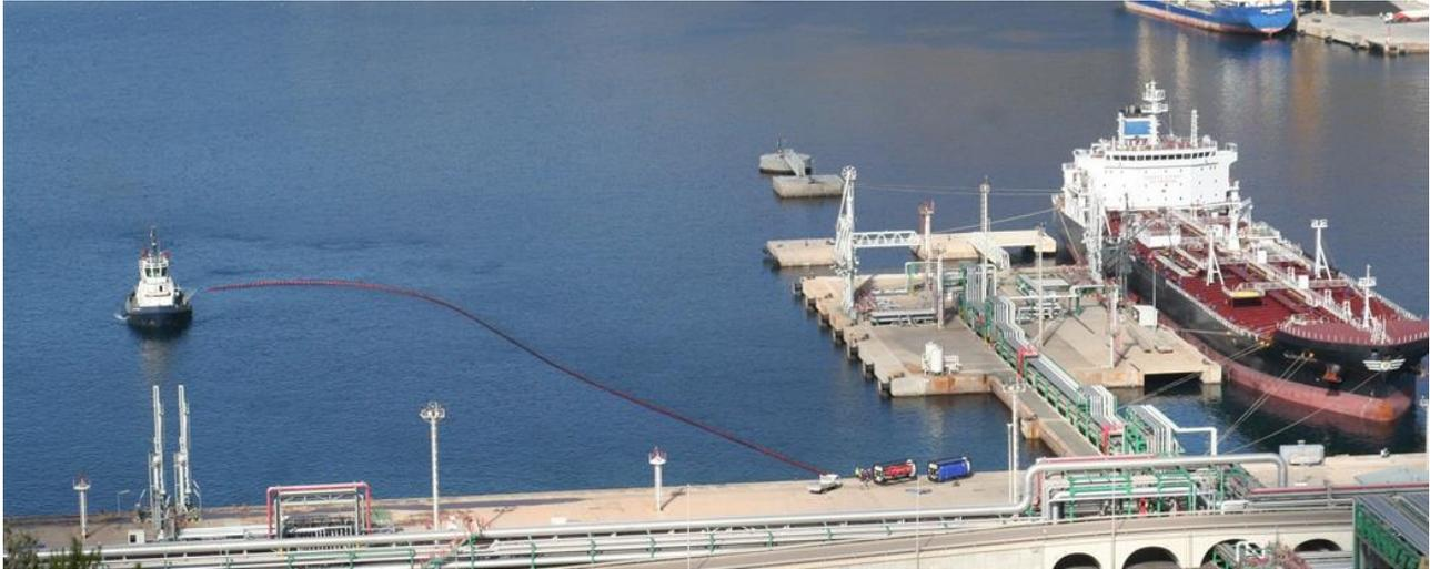
Despliegue de barreras periódico para mantener los equipos listos ante cualquier emergencia. Terminal Marítimo de Repsol
