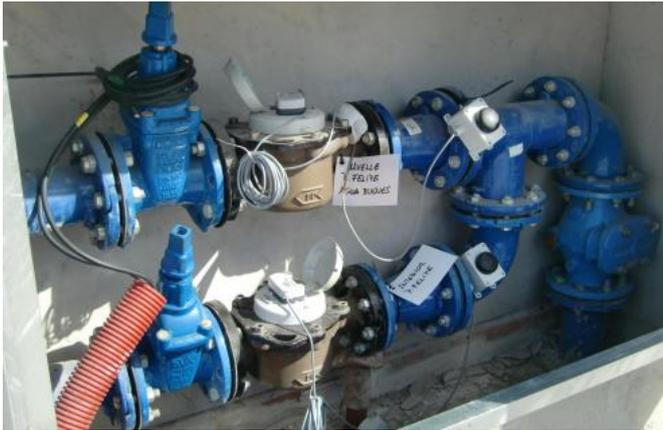
Contadores telemáticos para el control del agua a buques en Escombreras
