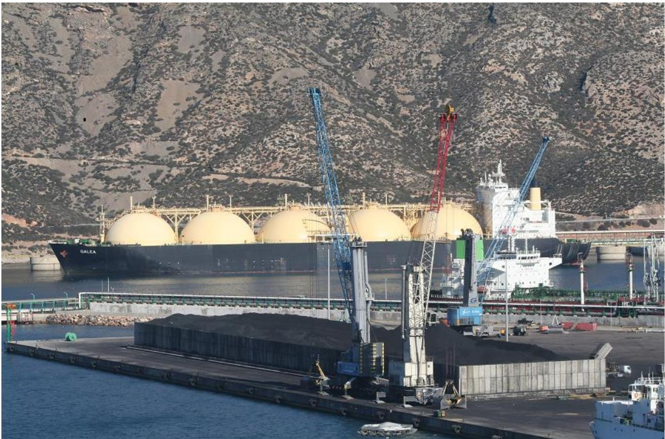
Acopio de coque entre muros para minimizar las emisiones de polvo
