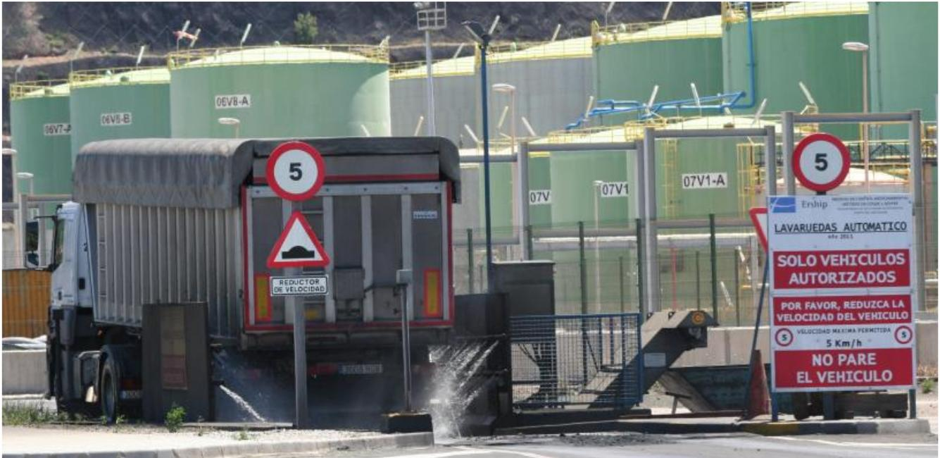
Lavaruedas automático instalado en la terminal de graneles para minimizar las emisiones de polvo procedentes del transporte
