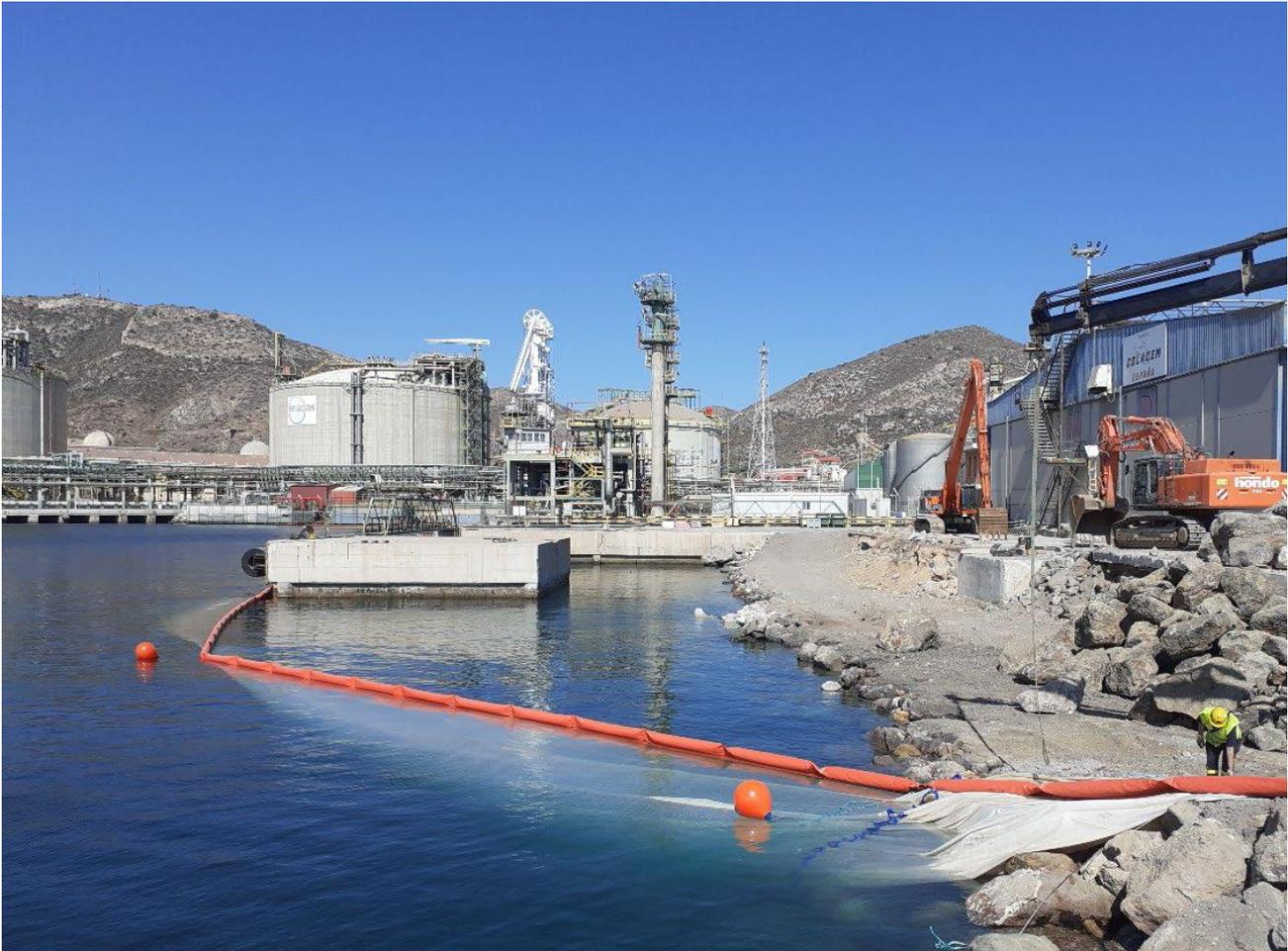
Barrera anti turbidez en las obras de ampliación del muelle para carga GNL en Escombreras
