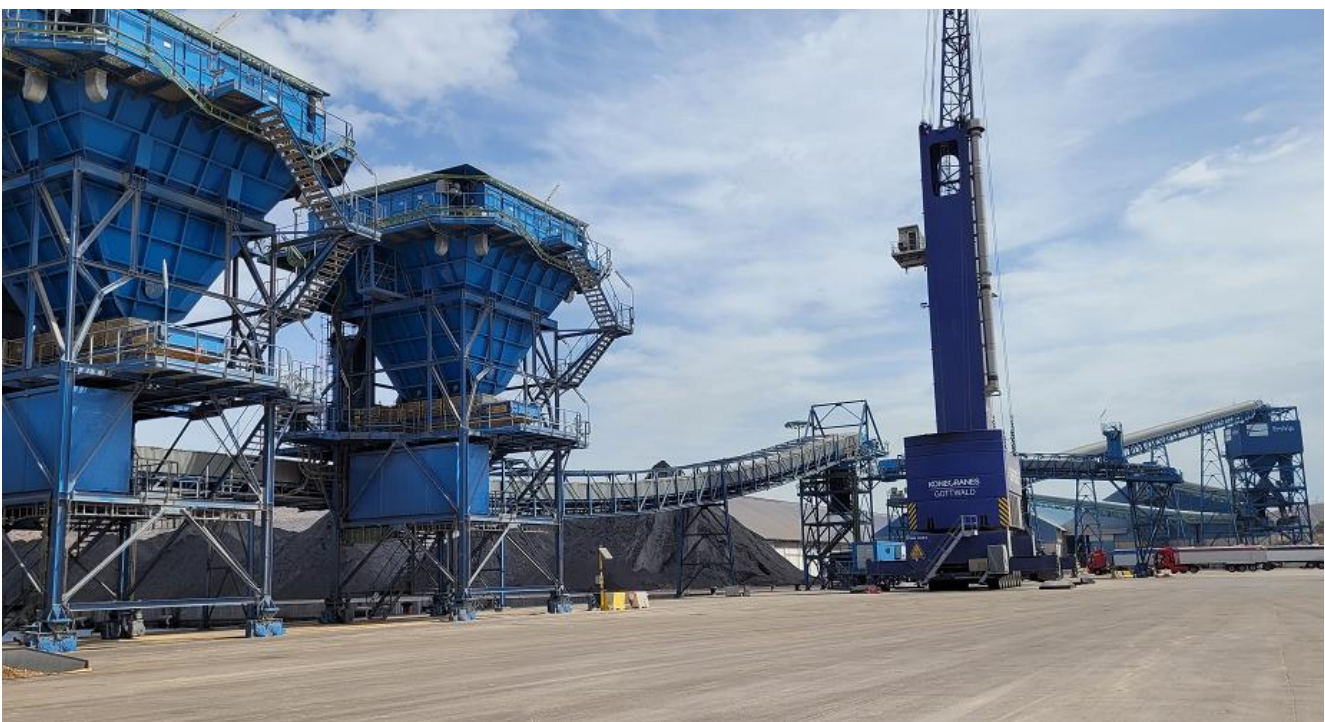
Nuevas cintas transportadoras y tolvas ecológicas para minimizar emisiones de partículas instaladas por Ership, S.A.
