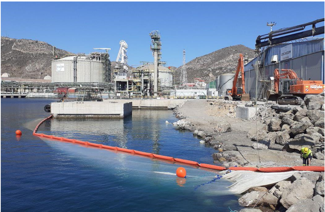
Barrera anti turbidez en las obras de ampliación del muelle para carga GNL en Escombreras
