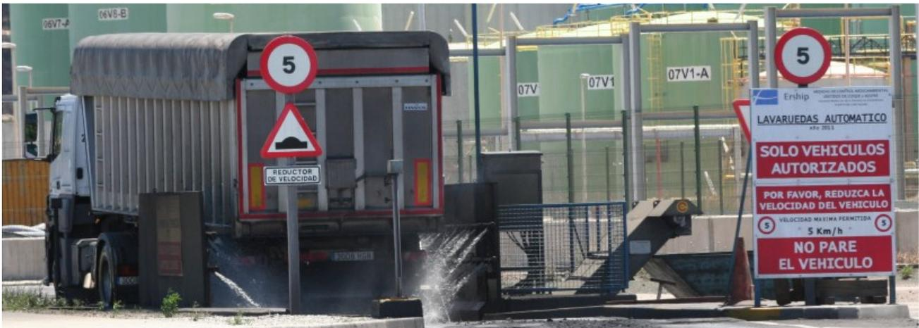
Lavaruedas automático instalado en la terminal de graneles para minimizar las emisiones de polvo procedentes del transporte
